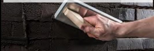
По методу поверхностной затирки швы заделываются с помощью расшивочной или штукатурной рейки. Настенные поверхности обрабатываются сверху вниз.
