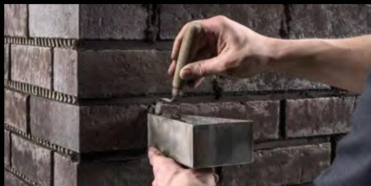
Вертикальные швы проще расширяются с помощью шпателя меньших размеров для расшивки швов.
