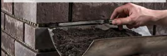
Расшивка с помощью мастерка для расшивки швов в горизонталях.
