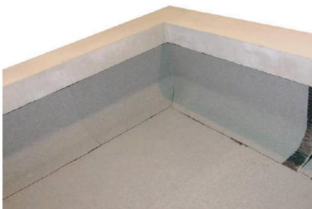
При формировании внутреннего угла кровли куски материала на примыканиях подрезают по месту.
