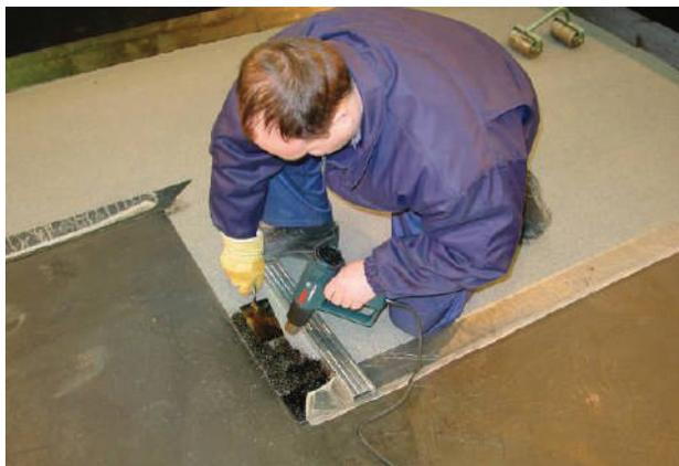
Места торцевых нахлестов, примыканий к различным конструкциям являются наиболее ответственными при выполнении кровли, поэтому им необходимо уделять повышенное внимание.
