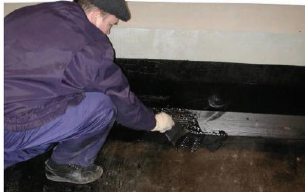
В местах установки пристенных желобов или свесов до установки отливов из оцинкованной стали также укладывают слой усиления. Материал слоя усиления должен заходить на фасадную часть на 100 мм и выступать из-под отлива из оцинкованной стали на 150 мм.
