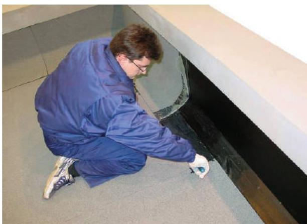
С места нахлеста на расстоянии 150 мм удаляют посыпку описанным ранее способом (используя фен горячего воздуха и шпатель).
