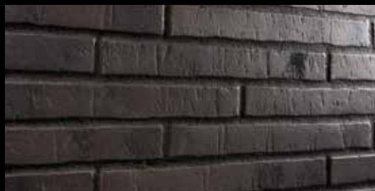
Готовый вид шва.
