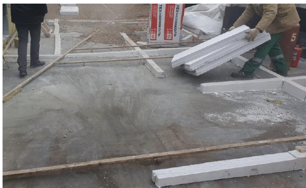
Фото 1 - Монтаж направляющих по заданному уклону
